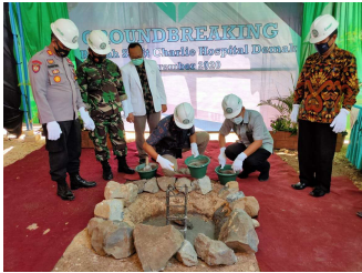
Pembangunan Rumah Sakit Charlie Hospital di Demak.
